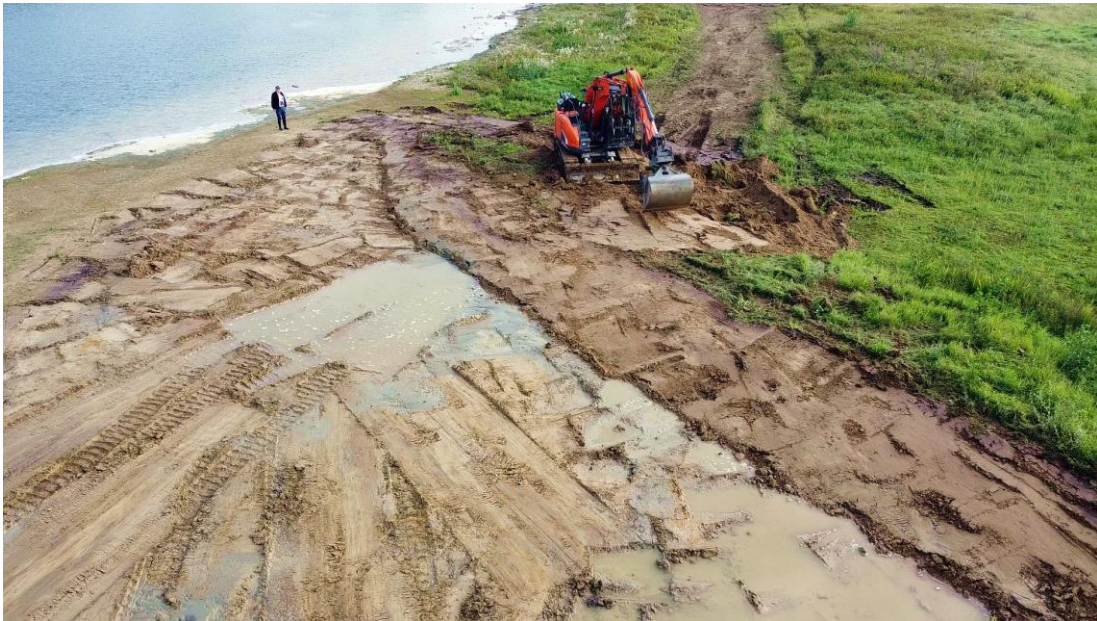
Baggerarbeiten im NSG-Zachariasse
